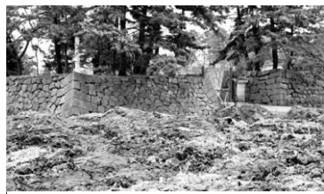
津城1970年代 (南西より西の丸大手橋前を撮る)
