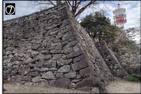
⑦ 大天守台と小天守台〔奥〕 □ 往時は織田信包創建の望楼型五重天守が建っていました。野面積みに近い打込みはぎで積んであり、隅部は算木積みに近い積み方です。南面には火災によると思われる黒い焼痕を見ることができます。大天守台前の犬走りは約 8m ありました。
