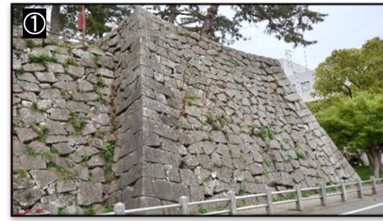
① 丑寅櫓台 □ 隅部には石垣が最も崩れにくいとされる縦横比 2.5：1 の直線的な算木積み石垣を見ることができます。丑寅櫓は津城の鬼門（北東）を守る高虎考案の層塔型三重櫓でした。
