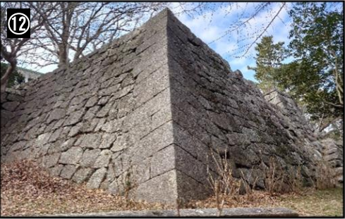
⑫ 大天守台の算木積み □ 隅部をまっすぐに積むきれいな算木積みが見られます。寛文期改修時のものです。大天守台の大きさは、南北 16m東西 14mあります。
