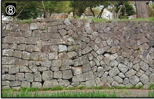
⑧ 本丸と西の丸の接続部 □ 石垣の積み方がはっきりと分かる場所です。左側が打込みはぎの布積み、右側が明治以降に積まれた谷積み（落とし積み）です。右側の部分は本丸と西の丸を結ぶ土橋となっていました。
