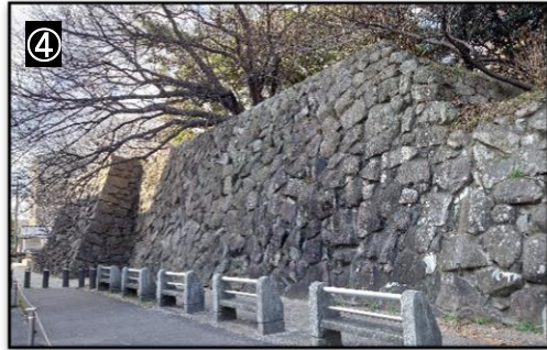
④ 東多門櫓台と月見櫓台 □ この部分の石垣は昭和 19 年（1944）の東南海地震で大きく崩壊しました。戦後に積み直されましたが、忠実に積まれておらず隅部も算木積みにはなっていません。石垣崩壊を防ぐために石垣の隙間にモルタルが注入してあります。
