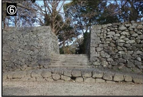
⑥ 埋門 □ 津城が火災に遭った時に本丸よりの脱出口として寛永16年（1639）に造られました。出た所にある幅約 4mの犬走りを回って東多門櫓・太鼓櫓下から城外に脱出できました。東側は野面積み・西側は打込みはぎ、両隅部は算木積みです。
