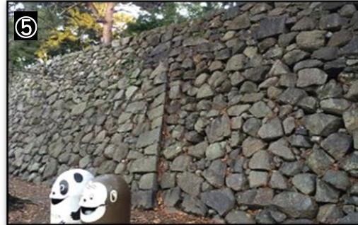
⑤ 南多門櫓台と旧隅部 □ この部分は津城を築いた織田信包時代の津城最古の野面積み石垣です（写真左側）。中央に見える隅部の出っ張り（旧隅部）は、高虎が津城を拡張した時に写真右側に広げた跡という説と石垣の補強のためという説などがあります。
