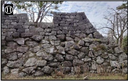
⑪ 大天守台 □ 織田信包創建の大天守台を藤堂高虎が改修したものです。入り口の切り裂きの奥には大天守の穴蔵があります。手前右側の石垣の崩れは、天守台取付多門櫓台を取り払った跡です。
