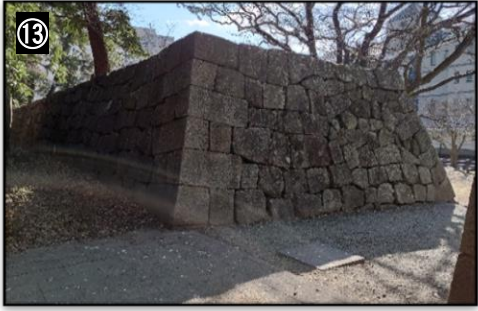
⑬ 埋門 □ 寛永16年（1639）に本丸よりの脱出口として造られました。きれいな算木積みと切込みはぎを見ることができます。石垣表面には「のみ」により「すだれ仕上げ」がしてあります。
