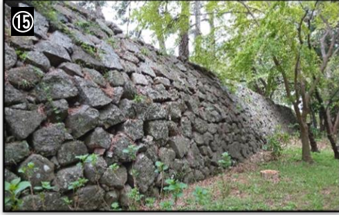
⑮ 北多門櫓台 □ 野面積みに近い打込みはぎの石垣です。「転用石」を見ることができます。石垣の上には幅約 6m長さ約 95mの長大な多門櫓が建っていました。
