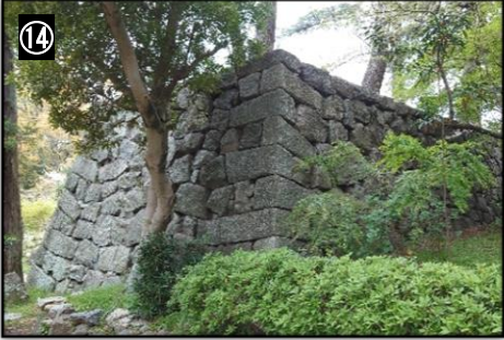
⑭ 西多門櫓台 □ 西鉄門が接続され「柵形」を形成していました。全ての面にたくさんの「刻印」を見ることができます。
