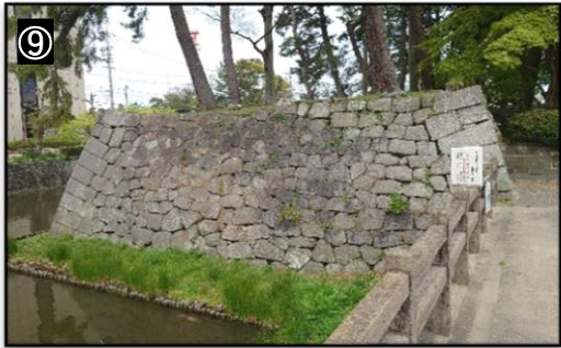
⑨ 西の丸玉櫓〔西の丸角櫓〕台 □ 西の丸には武器庫がありました。手前の木橋西側石垣上には玉櫓と呼ばれる鉄砲の弾丸を収める櫓が建っていました。石垣下の犬走りは石垣修理と石垣崩壊防止のために明治以降に造られました。
