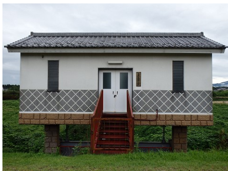
樋門建屋外観
