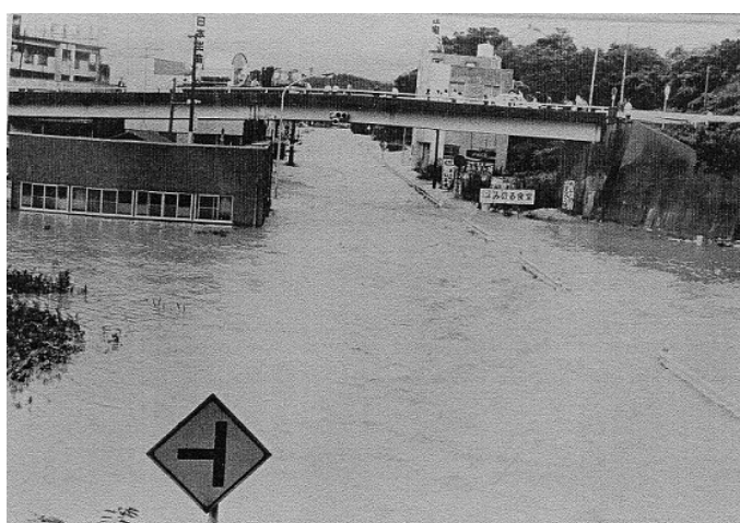
▲三笠屋旅館から駅へ通じる高架橋付近の様子
