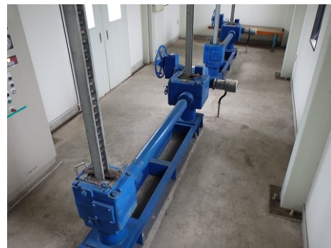
室内ゲート昇降装置
