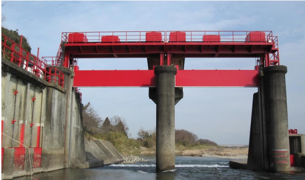
県営基幹水利施設補修事業の中で頭首工を改修後 15 年が経過しました。今後も良好に施設を維持管理していくため、国庫補助事業の維持管理適正化事業により、平成 23 年度、塗装工事を施工しました。総工事費約 900 万円のうち、本土地区改良区負担分は 15%で、5 年間の分割になります。
