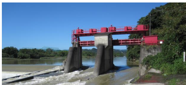
台風通過後の頭首工です
