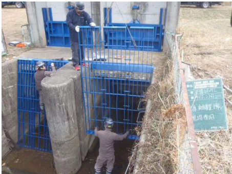
サイホン入ロスクリーン据付（戸木町）
