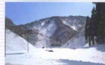
平成13年3月13日現在 ダムサイト付近
