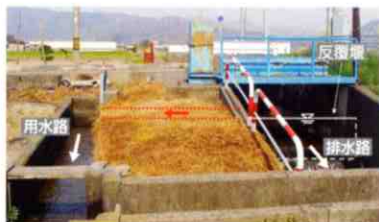
D.高月町東物部地区 反覆堰で排水路の水を用水路に導くことにより水が繰り返し利用されています。
