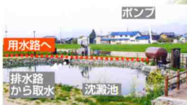
E.高月町西阿閉地区 排水路の下流に沈殿池を設け、水を浄化すると共に、ポンプで再び用水路に給水することにより、水が繰り返し利用されています。
