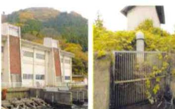
B.余呉湖補給揚水機場 排水路の水をポンプで汲み上げ用水路に給水します。
