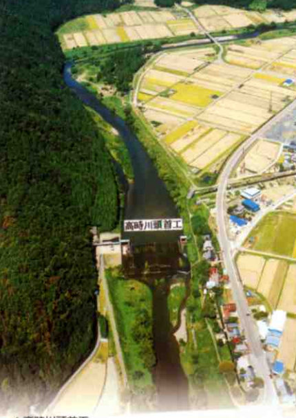
▲高時川頭首工 井明神橋付近には、下流の村々の井堰が6つ集中していました。昭和17年（1942年）に、それらを一つにまとめた合同井堰が完成し、現在の高時川頭首工は昭和43年（1968年）に完成しました。
