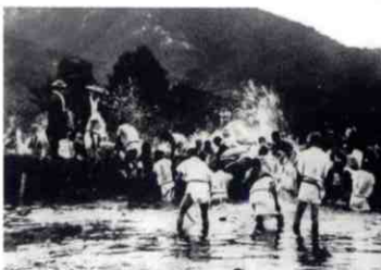
▲井落とし 「井落とし」は朝落とし、昼落とし、暮落としと、必要な時に行う時落としがあり、また用具を一切用いず、総て素手で井を引き抜き水を下流に流しました。
