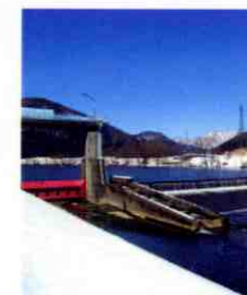
高時川頭首工 昭和43年完成。
